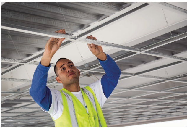
Instalación de T conectores.
