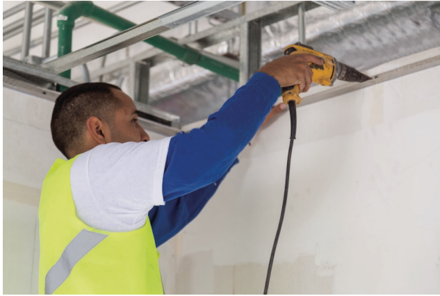
Colocación de Remate perimetral.
