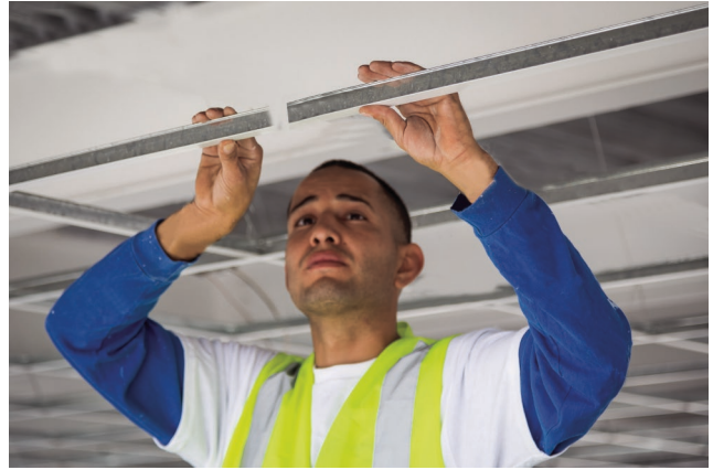
Instalación de T principal.
